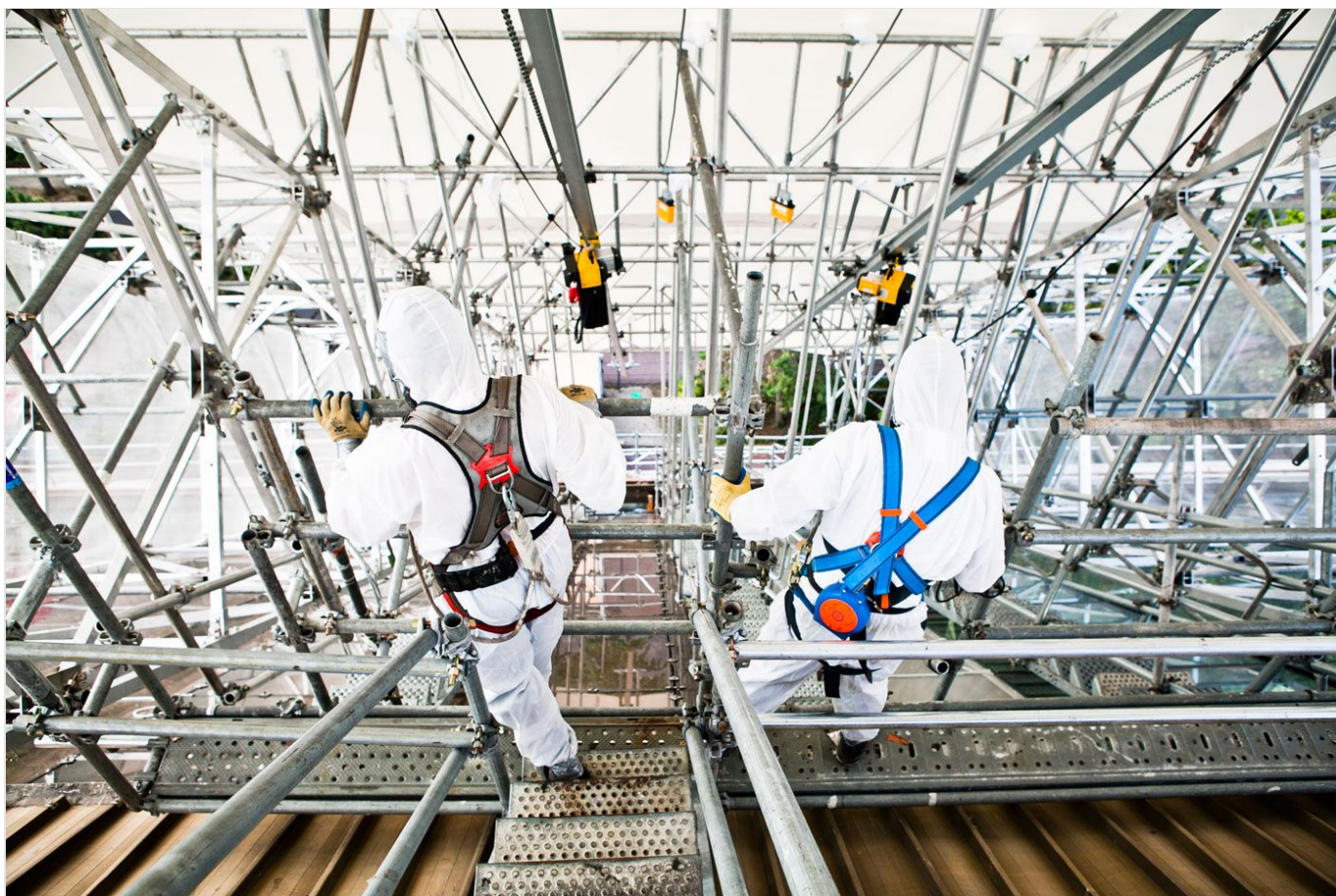
Opérateurs sur un échafaudage d'un chantier de désamiantage d'une verrière d'un hippodrome
