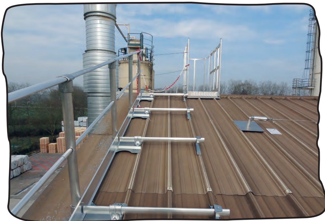
Exemple d'accès avec protection par garde-corps.
