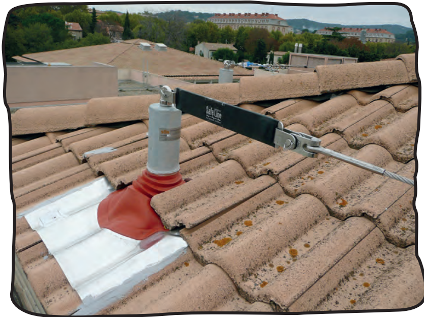
Exemple d'ancrage structurelle terminale.
