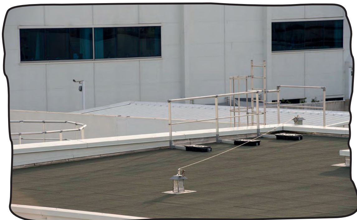
Exemple d'accès avec protection par garde-corps.
