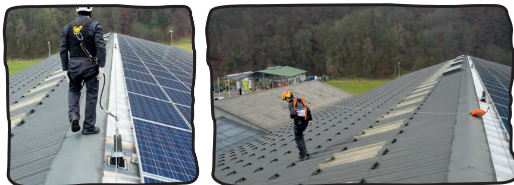
Ligne de vie au faîtage
