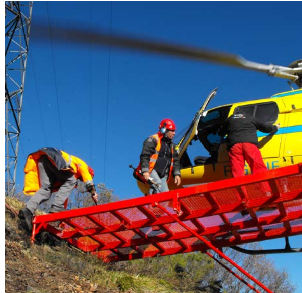
Plateforme amovible réglable pour s'adapter au dénivelé du terrain.
